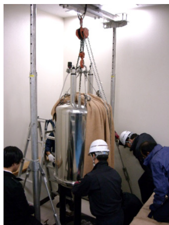
図 3 超伝導マグネットの撤去
